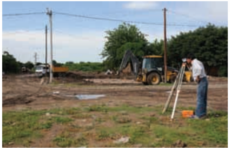
▲ Máquinas viales trabajando en la apertura de la avenida América
