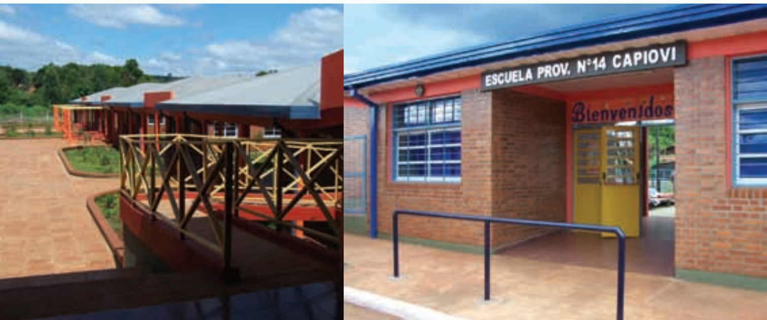
▲ Edificios escolares construidos por el IPRODHA para el presente ciclo lectivo ▲
