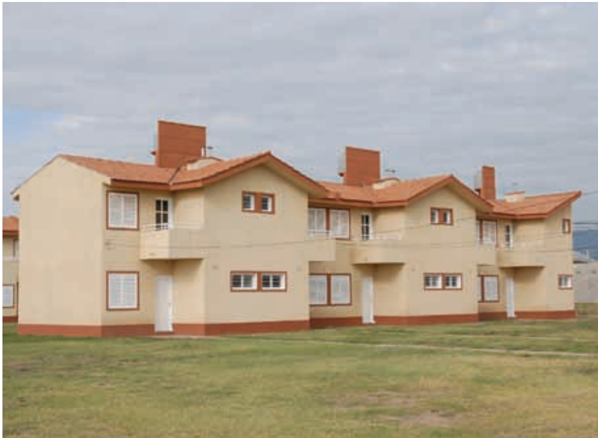
▲ Vista de un conjunto de duplex del sector XIV
