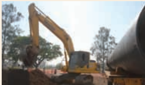
▲ Máquinas trabajando en la construcción del acueducto de Lomas de Tafí
