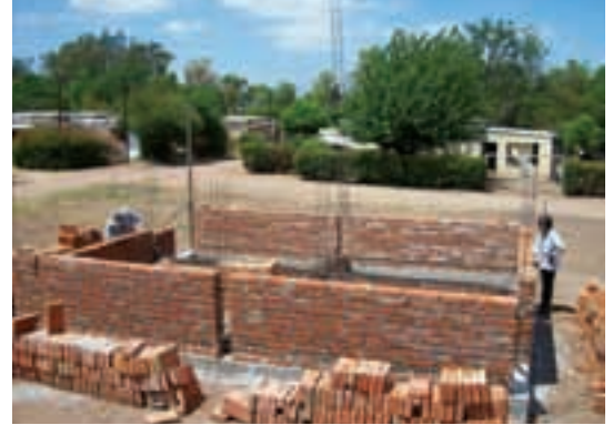
▲ Puesto Viejo, estructura, cemento y encadenado
