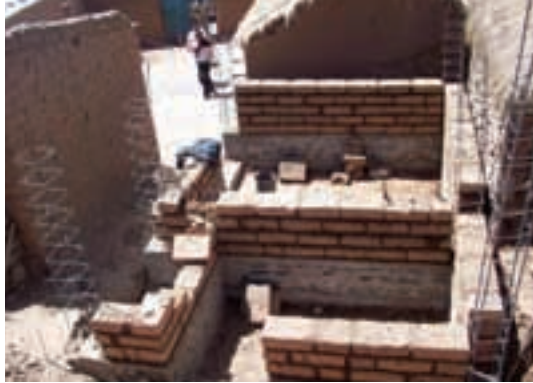
▲ Santa Catalina, estructura, cemento y encadenado
