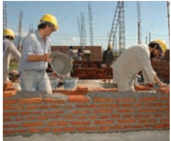
▲ Lomas Norte Sector Norte 1.400 viviendas. Obreros trabajando
