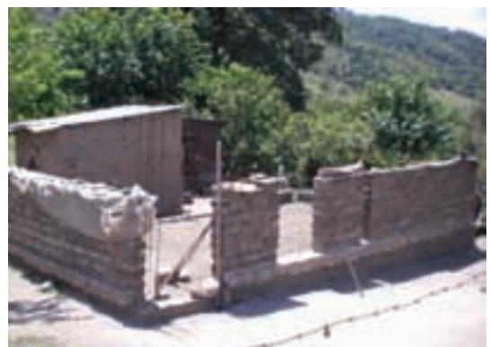
▼ Vista de la construcción de viviendas en El Nogalito, en el programa PRO.MAT.
