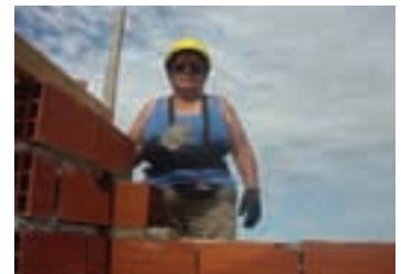
Mujeres albañiles rionegrinas construyendo sus viviendas ▶
