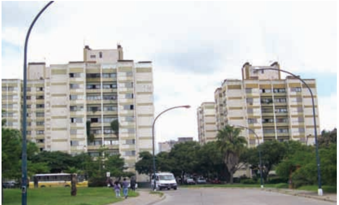
▲ Monoblock "R". Obra Fo.Na.Vi. terminado con Reactivación
