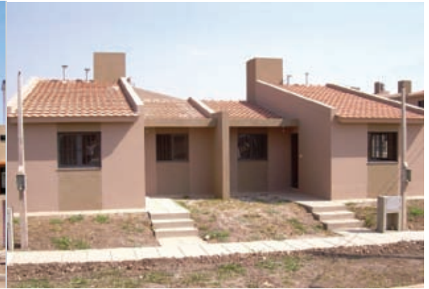
Vivienda en planta baja: conformación exterior ▲
