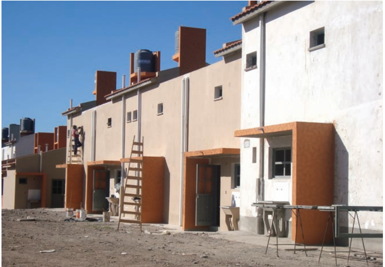
▲ Viviendas en dúplex: cara posterior y lavaderos resguardados por aleros y muros contiguos
