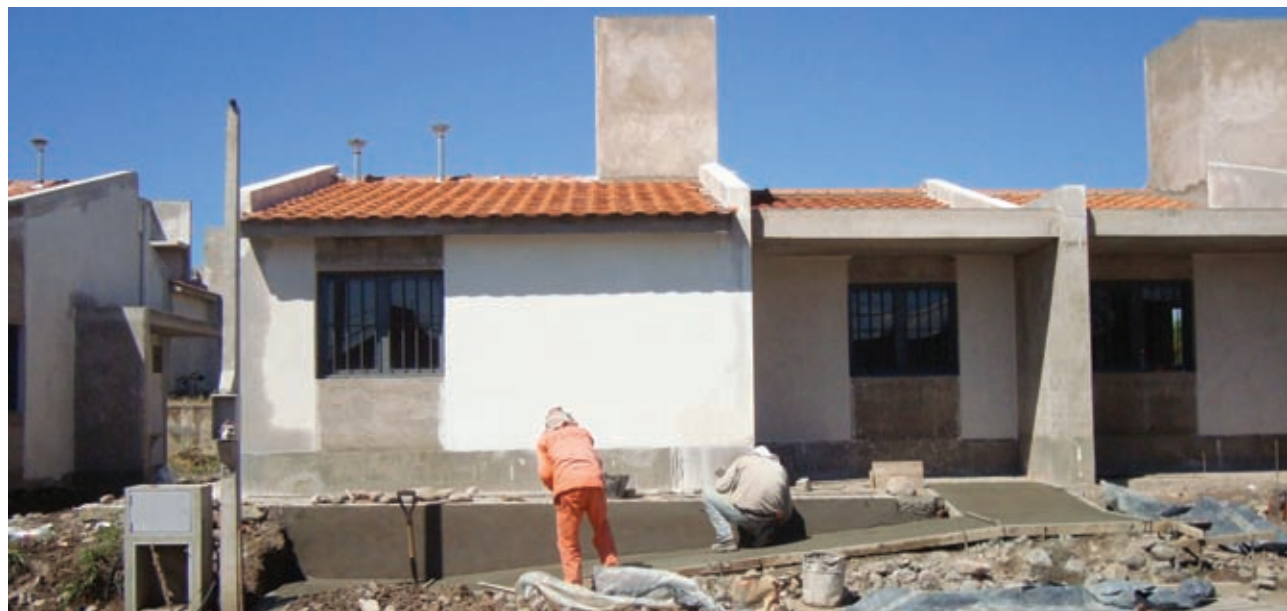
▲ Vivienda discapacitados. Accesibilidad en ingreso
