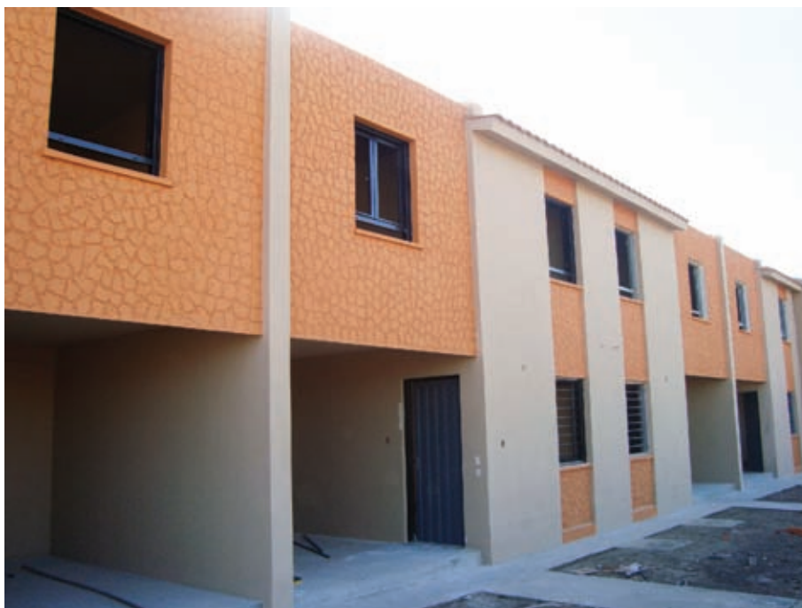
▲ Viviendas en dúplex: su conformación en planta baja permite futuros crecimientos y actuales galerías
