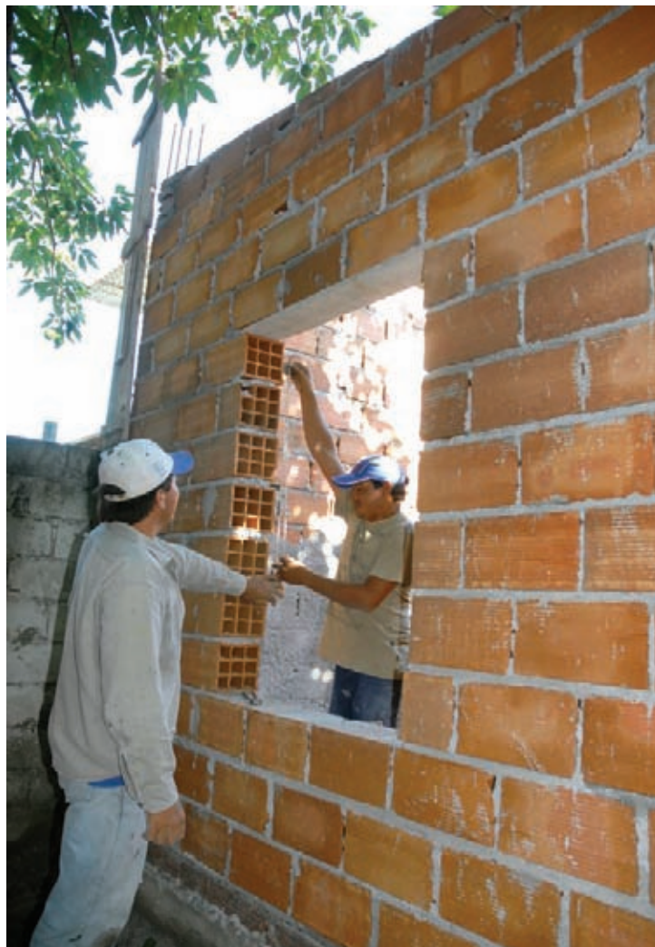
Barrio El Molino. ▶ Construcción módulo habitacional
