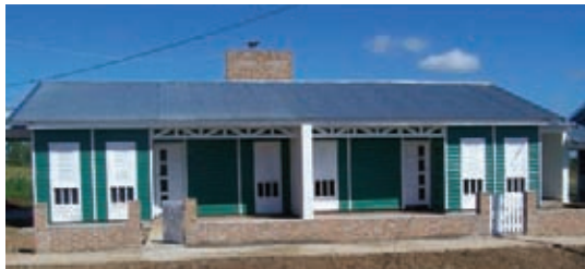
63 viviendas en inicio de obra. Inversión: $ 7.812.000.
