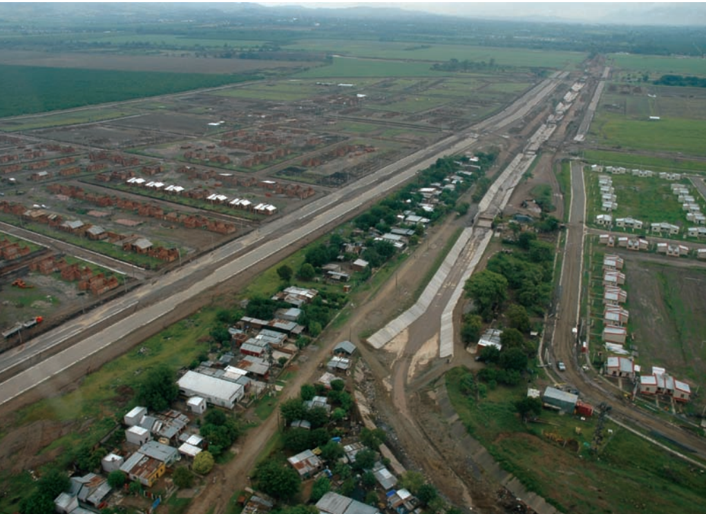
▲ Vista aérea de la infraestructura del complejo habitacional de 3.000 viviendas en Lomas de Tafi, observando la Av. Central del emprendimiento, Av. América, el canal Muñecas de desagüe a la izquierda, dos sectores de los 10 del complejo de las 3.000 viviendas y a la derecha parte de las 600 viviendas.
