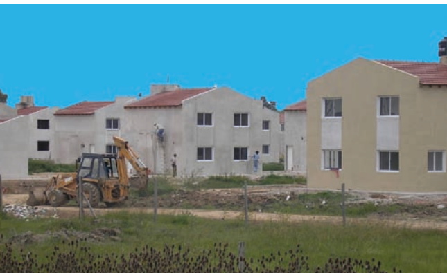
PFCV - Subprograma de Urbanización de Villas y Asentamientos Precarios La Plata - Bajada Autopista - 410 viviendas
