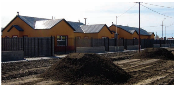
◀ Viviendas Plan Federal I, Río Gallegos, entregadas en el mes de octubre
