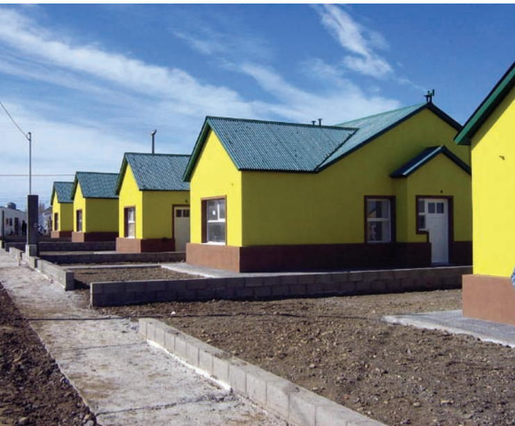
▲ Viviendas Plan Federal I, Río Gallegos, entregadas en el mes de octubre
