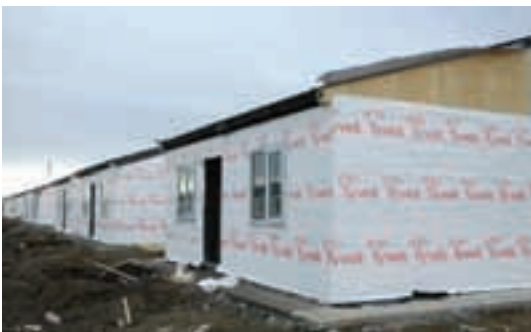
▲ etapa de la obra 3
