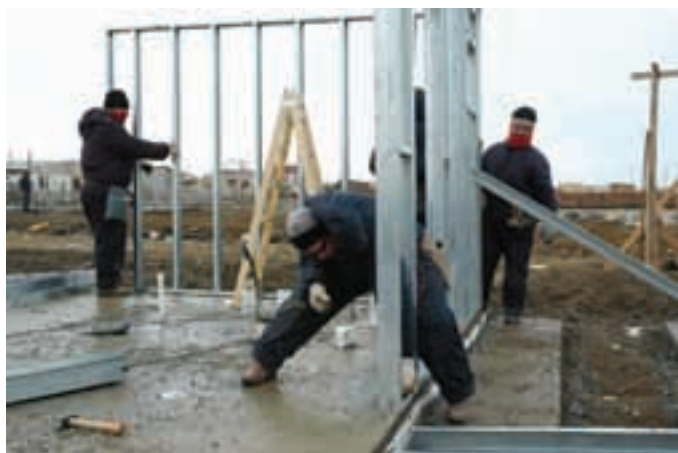
▲ etapa de la obra 1
