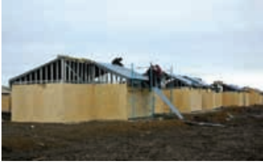
▲ etapa de la obra 2
