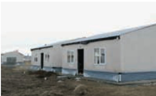
▲ etapa de la obra 4
