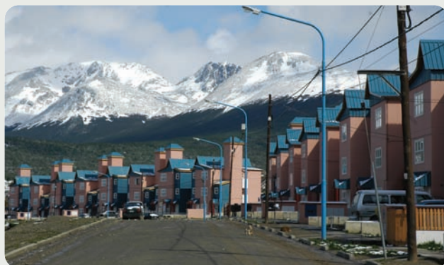
▼ 60 viviendas - Ushuaia. Sobre Avenida Héroes de Malvinas.
