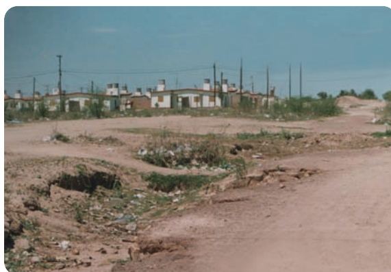
▲ Calle erosionada por acción de la lluvia antes de ser pavimentada
