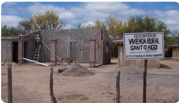
▲ Vivienda en construcción. Termas de Río Hondo
