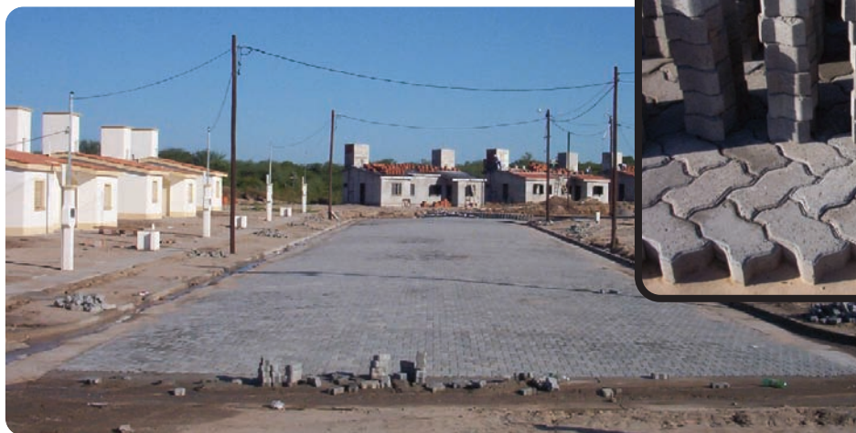
▲ Colocación en ancho de la calzada
