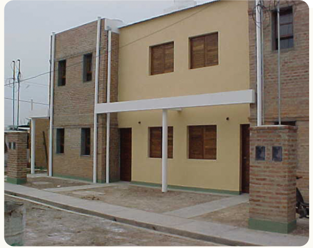
▲ Fin de la obra
