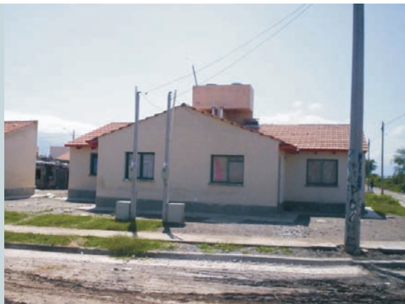
"8 viviendas" en Vinalito - Dpto. Sta. Bárbara.
