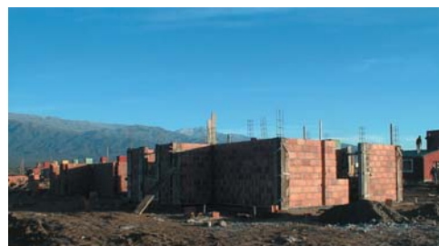
Lic. N°80/04 - 50 viviendas Capital (Zona Sur) - Empresa Jorge Marcolli
