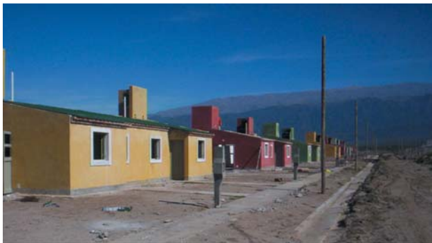
Lic. N°03/04 - 40 viviendas Capital (Zona Sur) - Empresa Jorge Marcolli
