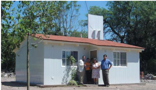
Emergencia Sísmica - Dpto. Capayán Sistema Constructivo "Royal Building System" - Tipología Urbana
