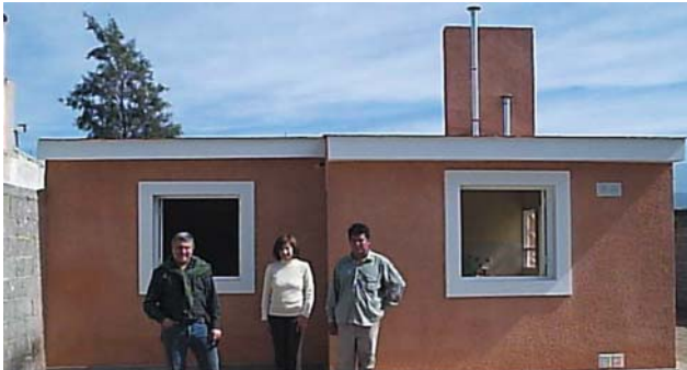
Emergencia Sismica - Dpto. Capital Sistema Constructivo Tradicional
