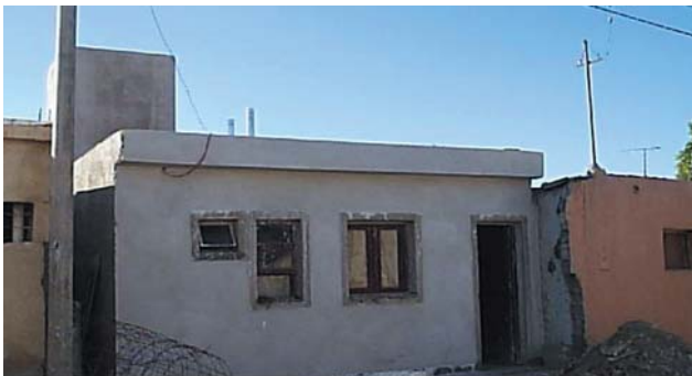
Emergencia Sismica - Dpto. Capital Sistema Constructivo Tradicional
