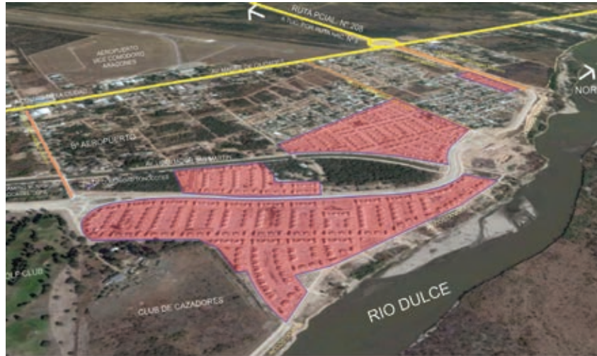
▲ Vista aérea del complejo habitacional Lomas del Golf, 892 viviendas e infraestructura en el Barrio Aeropuerto, Ciudad de Santiago del Estero
