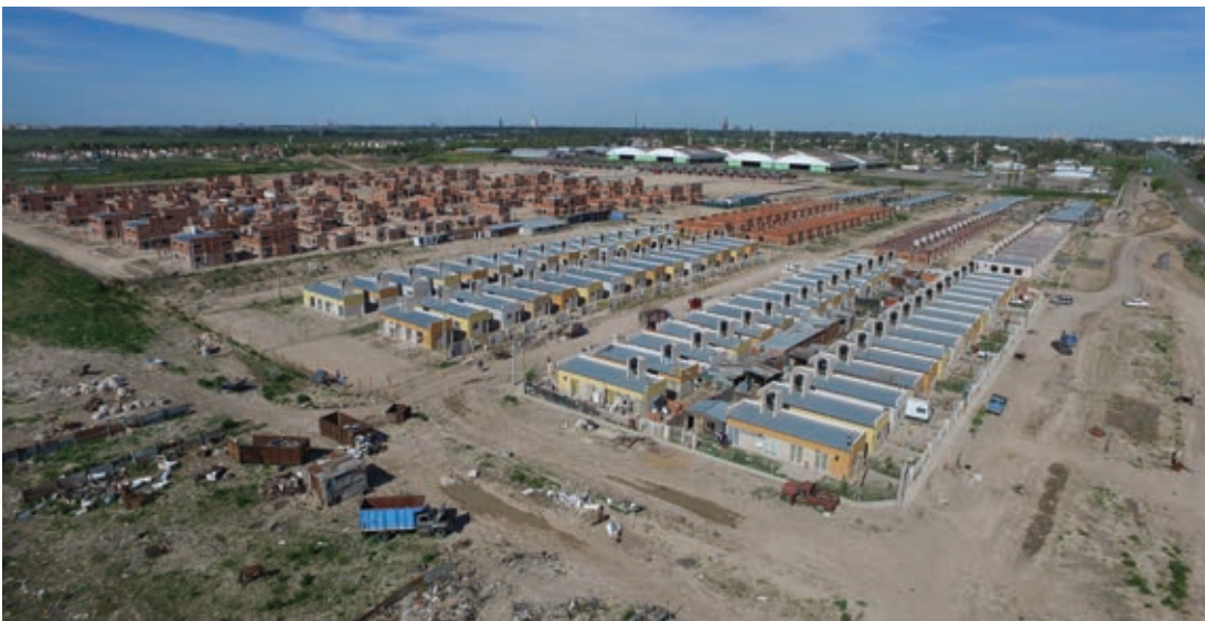
Viviendas provisorias y construcción de viviendas definitivas ▲
