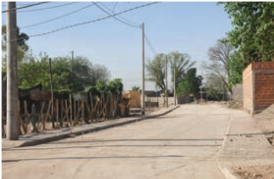
▲ Vista de apertura de calles en la urbanización Riberas del Salí
