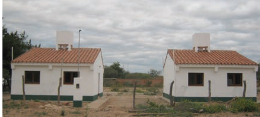
▲ Viviendas para personal médico en La Unión, departamento de Rivadavia, Salta
