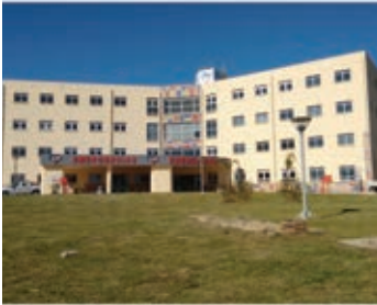
▲ Área de emergencias del Hospital Pediátrico
