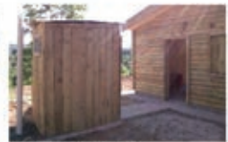
Solución para inundados 115 ejecutados 56 en ejecución
