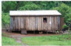
Cambio de cubierta de techo 77.899 ejecutadas 12.508 en ejecución
