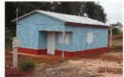
Vivienda misionera IV 342 ejecutadas 296 en ejecución
