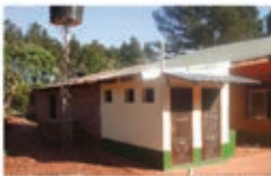
Núcleo Sanitario para aula satélite 29 ejecutados 8 en ejecución
