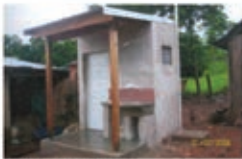
Baño con lavadero 355 ejecutados 32 en ejecución
