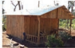
Techo, Cerramiento y piso 981 ejecutados (150 aborígenes) 344 en ejecución
