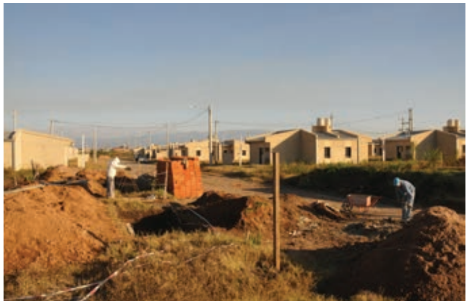
▲ Vista de la construcción de las casas para la relocalización
