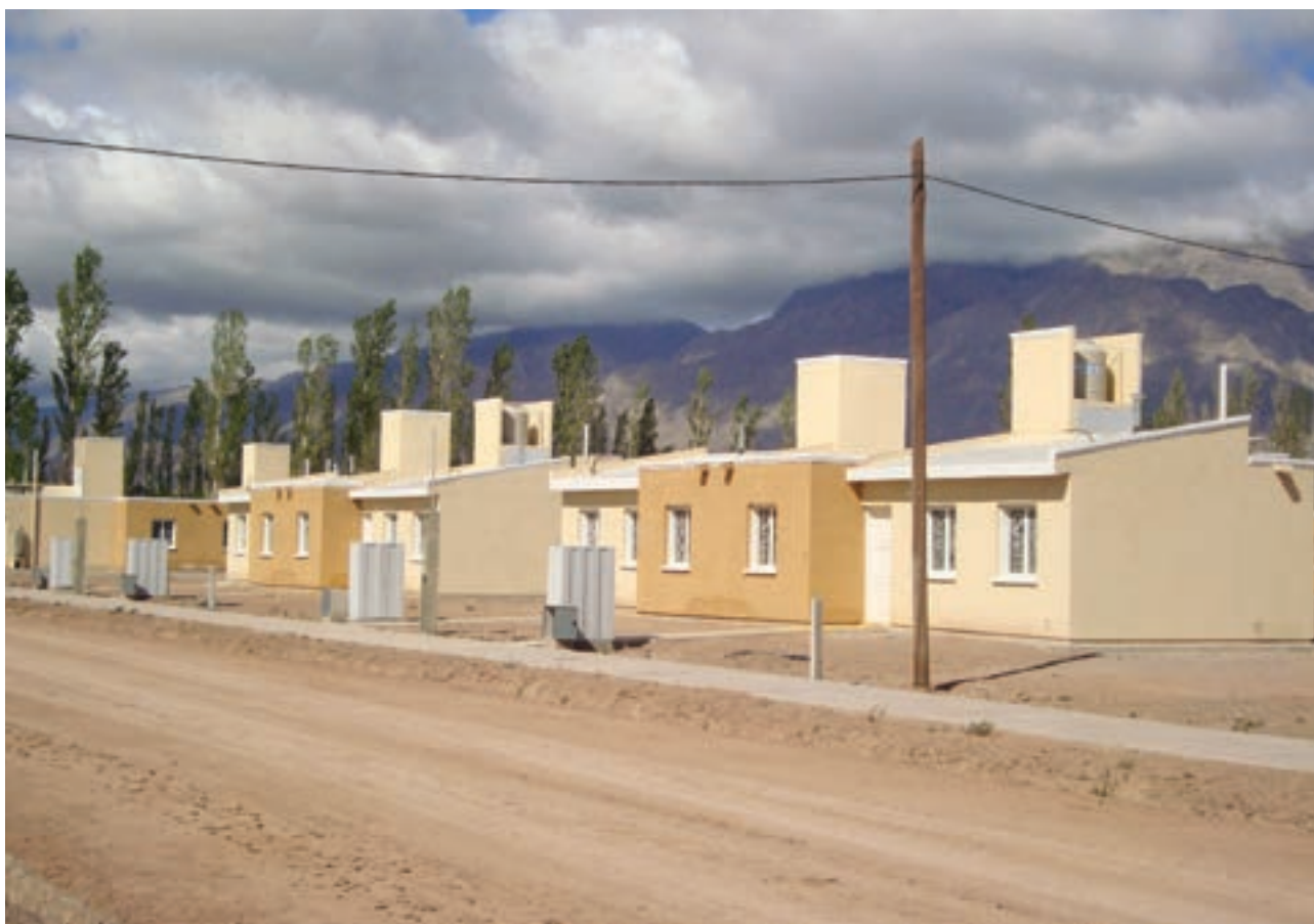
▲ Conjunto 3, Carpintería, Programa Federal Plurianual de construcción de viviendas Techo Digno.
