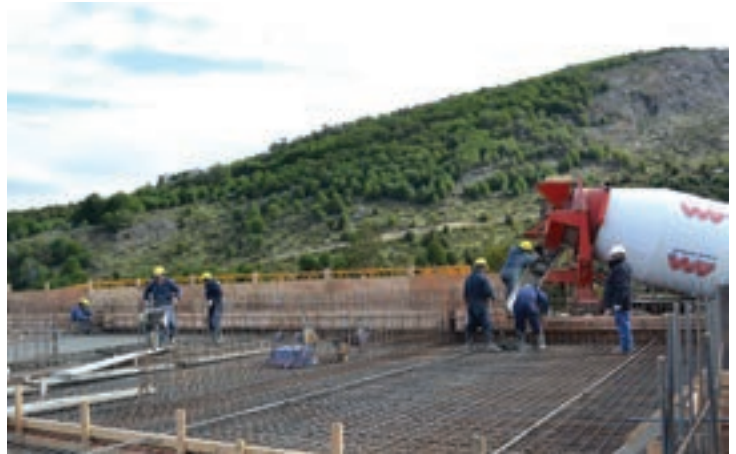
▲ Se trabaja arduamente en el avance de obra
