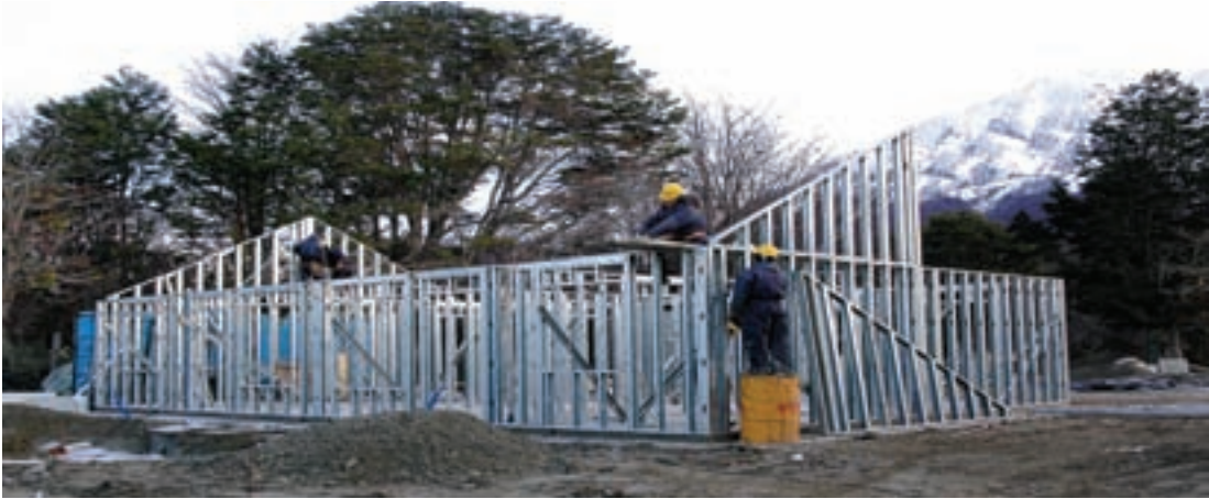
Viviendas en construcción ▲
