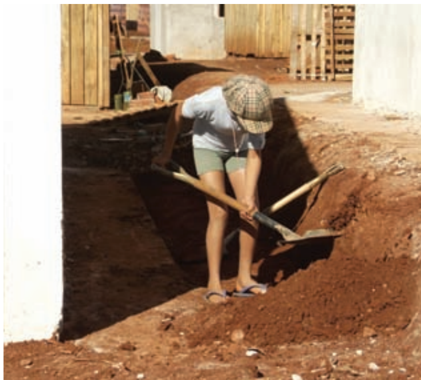
▲ Mujeres de las cooperativas trabajando en la construcción de viviendas
