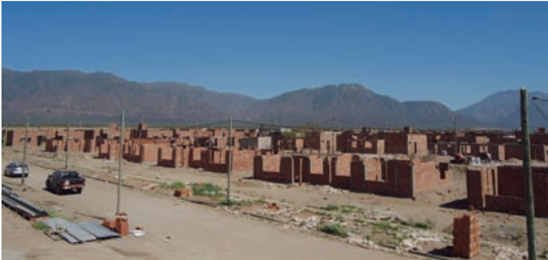
▲ Viviendas en ejecución, año 2011
