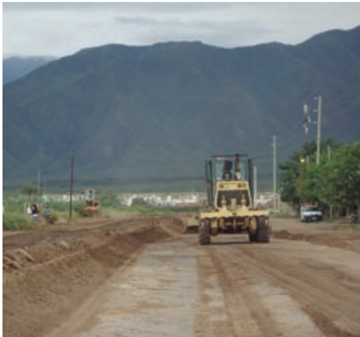
▼ Obras de pavimentación en acceso al barrio
