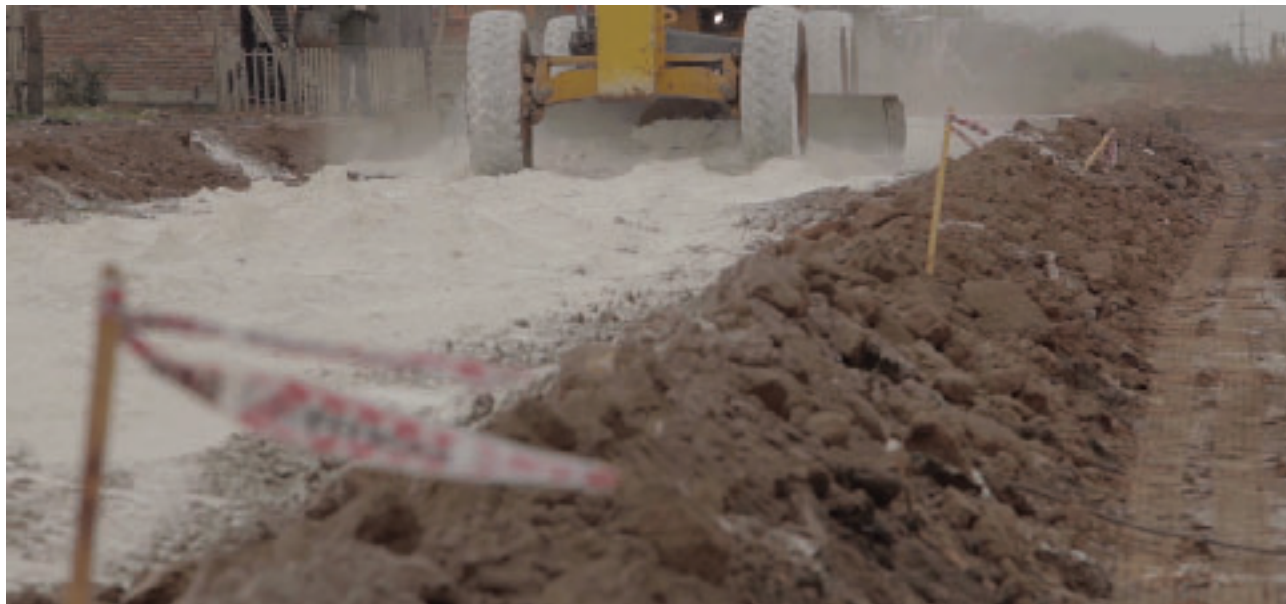
▲ Trabajos de apertura de calles en Rosario.
