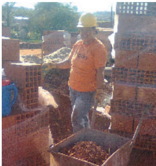
María Martínez colaborando en la construcción de la vivienda que pronto habitará. ▼
