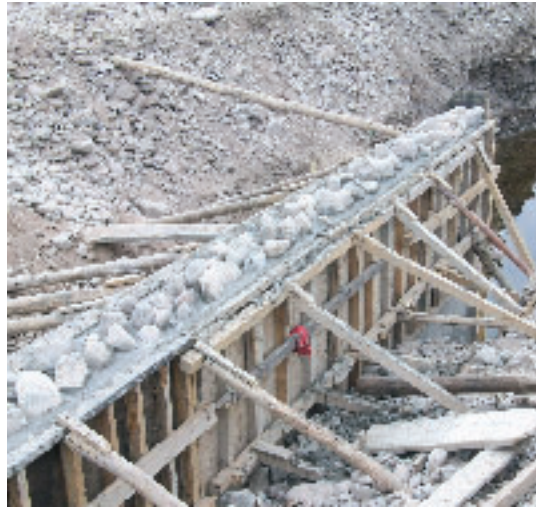
Muro de contención Río Xibi-Xibi ▲
