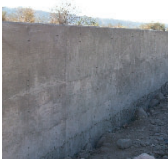
Muro contención sobre margen Río Grande ▲
