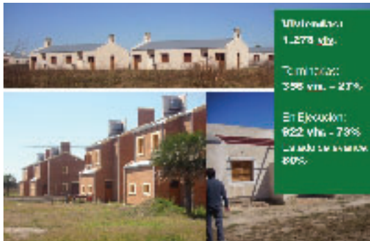
▲ Estado de las viviendas
