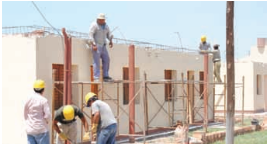
▲ Avance de obra en Pozo del Tigre
