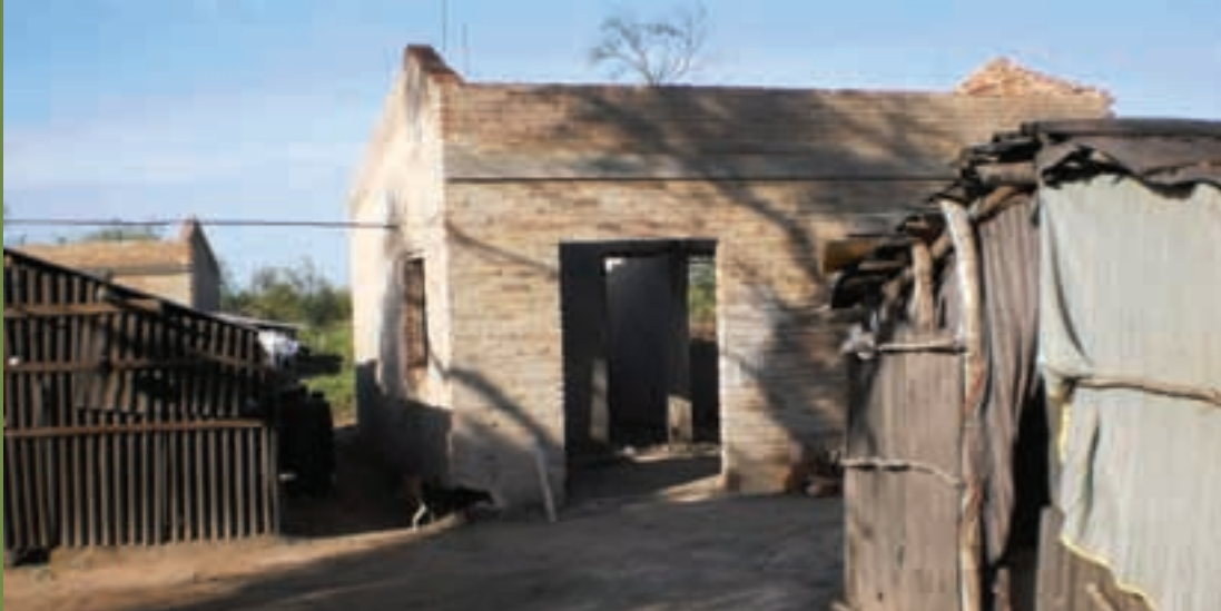
▲ Avance de obra en Pozo del Tigre
