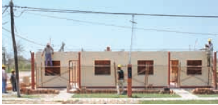
Avance de obra en Pozo del Tigre ▲
