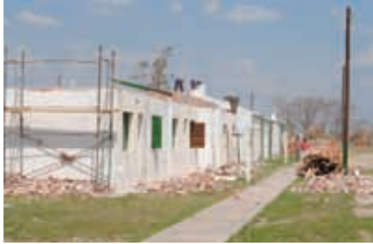
▲ Avance de obra en Pozo del Tigre ▶
