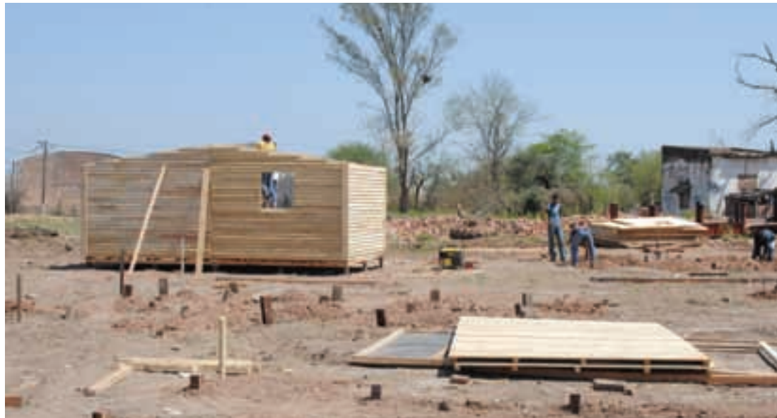
▲ Avance de obra en Pozo del Tigre
