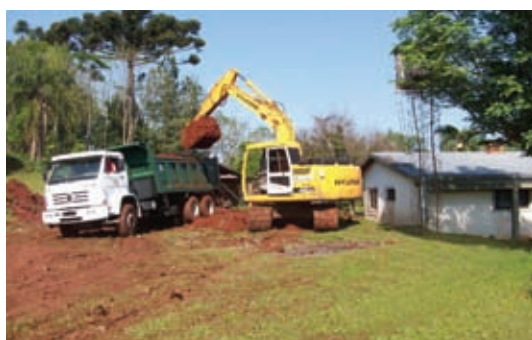
▲ Obras en la Escuela 613
