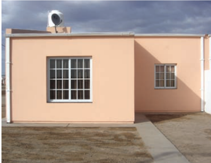
▲ Viviendas en La Reforma
