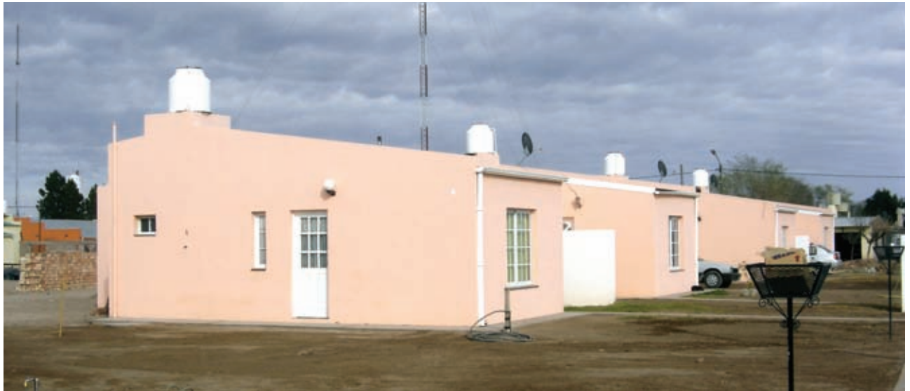
Viviendas en La Reforma ▲
