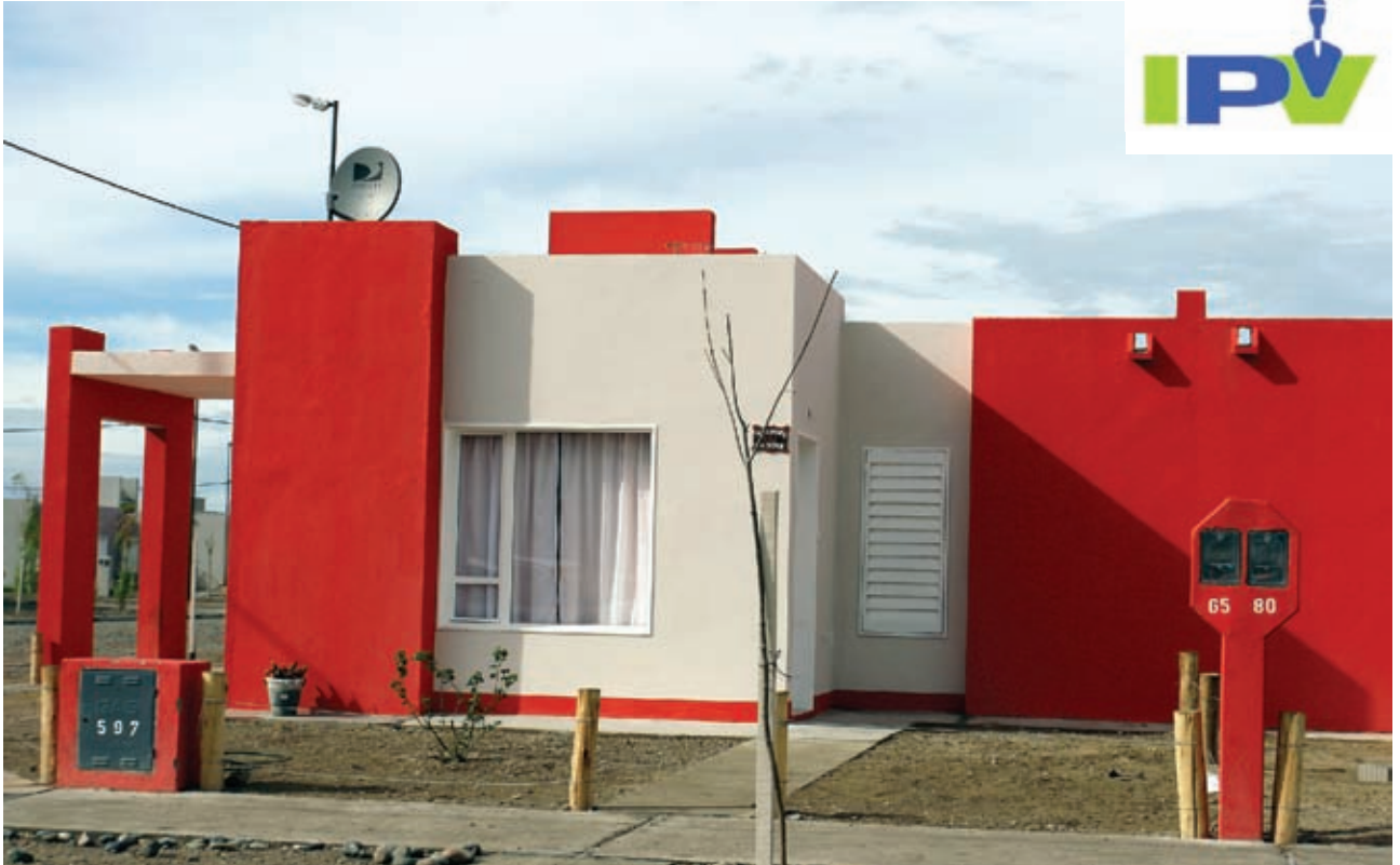
▲ 120 viviendas en Rawson - PFPCV
