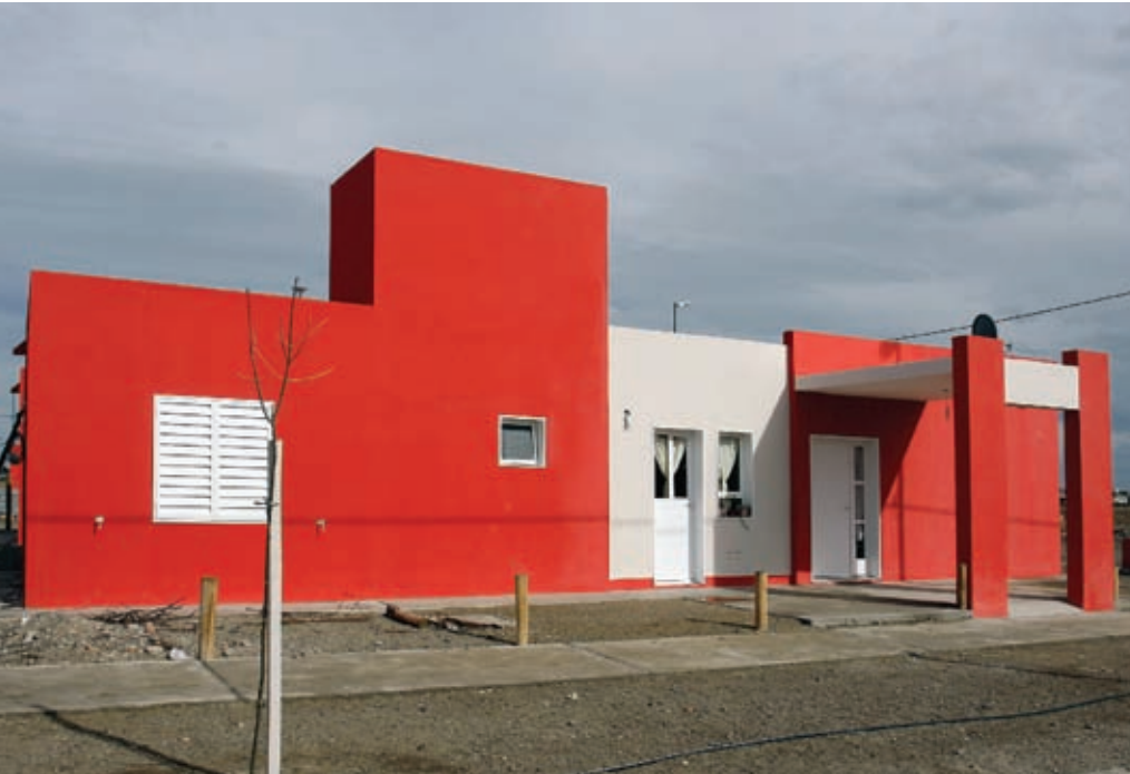
120 viviendas en Rawson - PFPCV ▲
