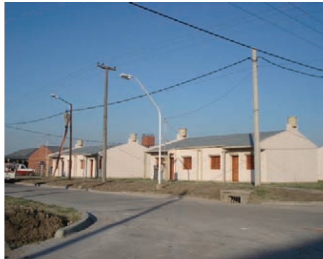
▲ Viviendas barrio 17 de Octubre
