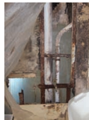
▲ Cielorraso deteriorado por humedad
