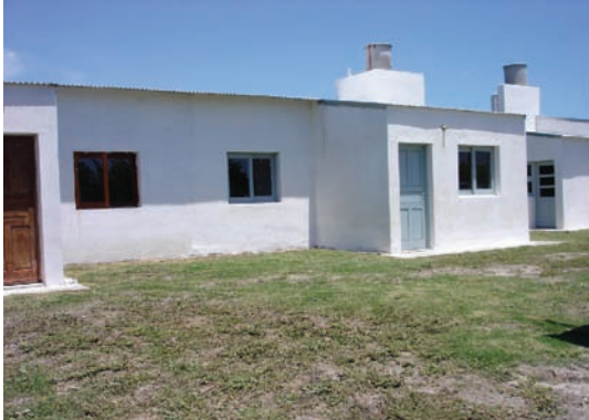
▲ Viviendas pertenecientes al Plan Federal de Emergencia Habitación - Ciudad de Malabrigo - Depto. Gral. Obligado
